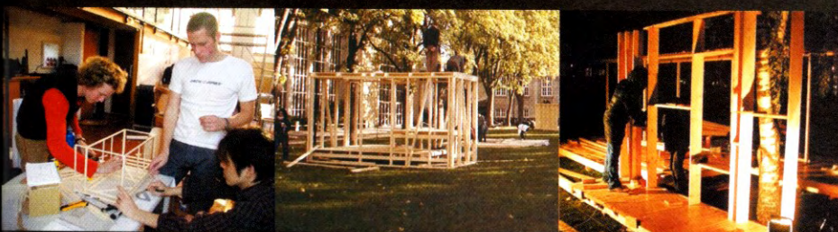
左：模型による施工の検討（GROUP2）。／中：施工風景（手前はGROUP2）。／右：夜間も作業が続けられた（GROUP4）。194-197頁の写真提供：東京大学ワークショップ参加メンバー。
